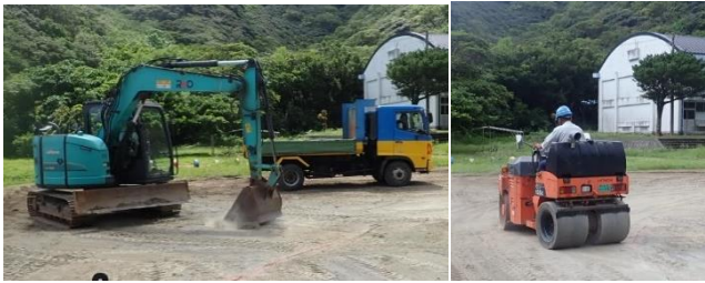
【重機による整地作業の様子】
