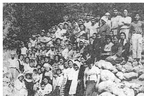
【防波壁完成時の写真(昭和30年3月)】
