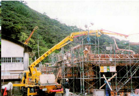
現在の校舎建築の様子
