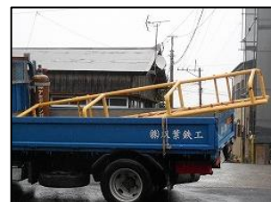
正門門扉補修
