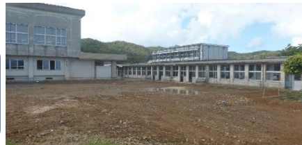
文責： 数か月前の敷地。改めて建築技術の高さ、スピードにただただ驚くばかりの幸田
